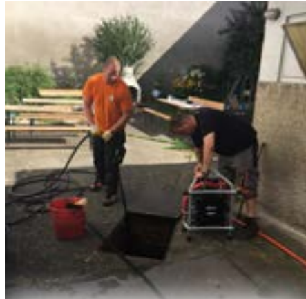
Juli: Erste Schritte zur Kanalsanierung. Das wird sich noch länger hinziehen...
